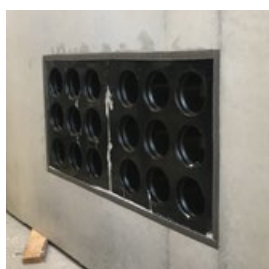
Betonová šachta je vybavena všemi potřebnými prostory
